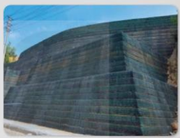
c) Xây bờ kè
