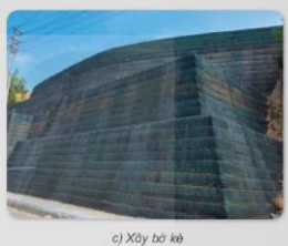
c) Xây bờ kè
