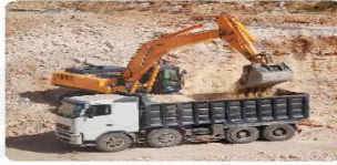
b) Máy xúc đất
