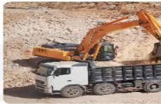
b) Máy xúc đất
