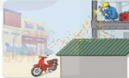
d) Xe máy để gần nơi hàn điện
