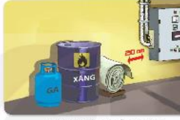
b) Chất đốt để gần tủ điện
