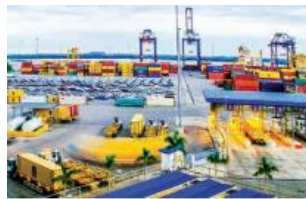
▲ Hình 5. Cảng biển quốc tế trong Khu công nghiệp
